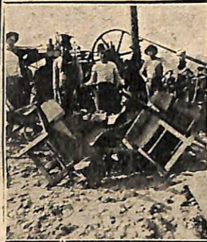
Trabajos de construcción del canal entre San Ramón y Monteagudo.—Grupo de obreros.
