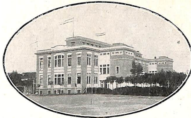
Conjunto del edificio que ocupa la escuela inaugurada el domingo en Bernal.
